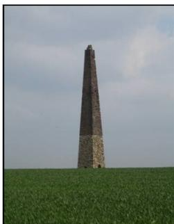
« **La cheminée** » : à l'origine, relais pour le télégraphe Chappe et depuis, point géodésique (point du terrain dont on a déterminé les coordonnées de façon très précise). Ces points doivent être visibles de loin.
